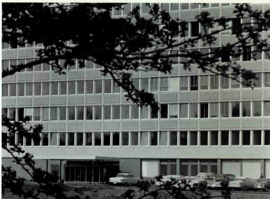
Haupteingang zum Gebäude der SRG an der Giacomettistrasse 1 in Bern, das am 8. Juni 1962 offiziell eingeweiht wurde
