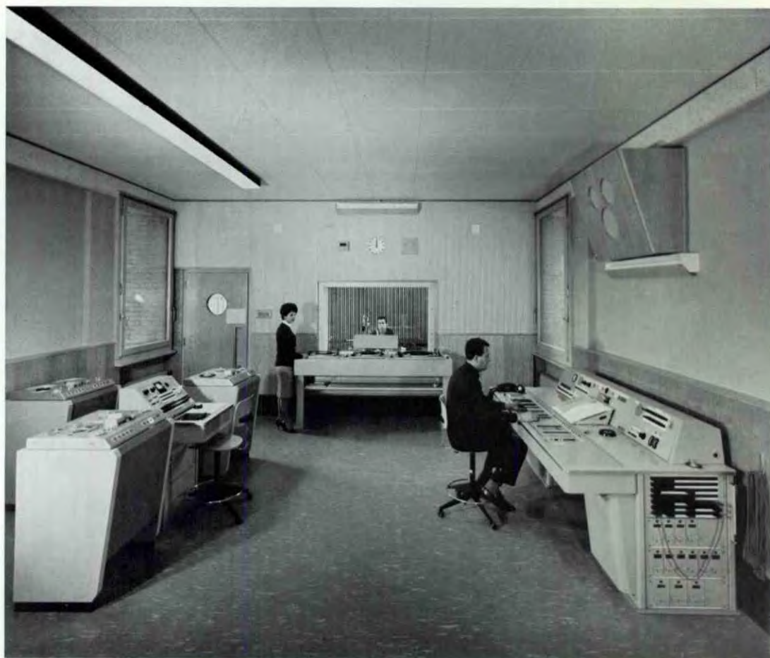
Un centro di trasmissione «T» di uno dei «complessi T+S». In primo piano, a destra, il pulpito di comando; a sinistra il gruppo dei magnetofoni. Sul fondo le macchine di riproduzione dischi. Attraverso la finestra di osservazione l'auditorio d'annunci S
