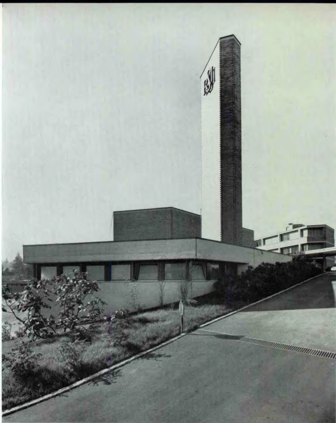
La centrale termica vista da nord, dalla rampa d'accesso. Sullo sfondo, a sinistra, parte dell'auditorio massimo; a destra, l'ala amministrativa
