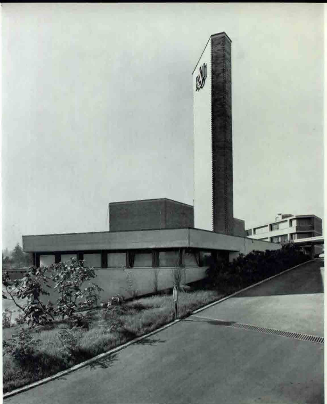
Zufahrtsstrasse mit der thermischen Zentrale von Norden gesehen. Links Teilansicht vom grossen Auditorium, rechts ein Flügel der Verwaltungsabteilung
