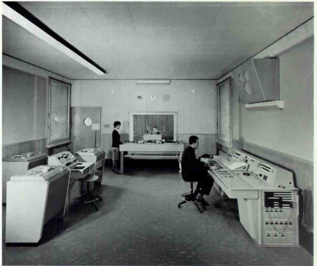
Ein Übertragungszentrum «T» der Komplexe «T+S». Rechts ein Kommandopult, links eine Aufnahmegruppe, hinten eine Plattenspielanlage. Durch das dahinter liegende Kontrollfenster Blick in ein Ansagestudio S
