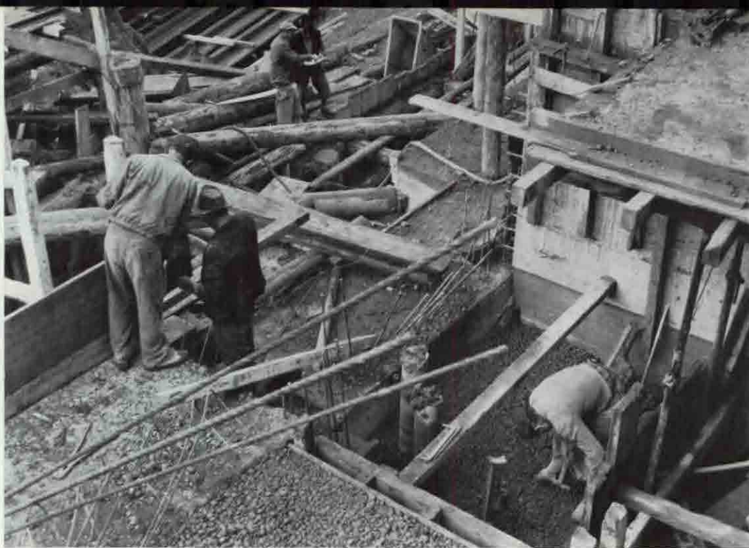
Un sujet intéressant pour une émission locale: des entreprises suisses de construction exécutent des travaux publics dans les territoires allemands voisins.
