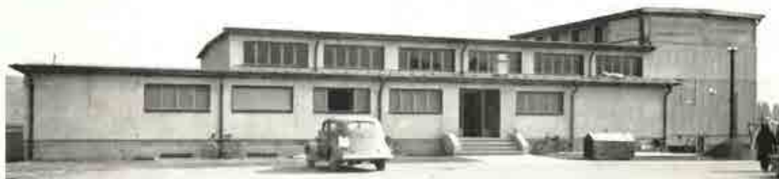
Neues Senderhaus und Verstärkerraum
